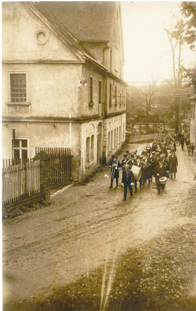
Diese 1924 gemachte Aufnahme zeigt gut den Transmissionsriemen zwischen Nr. 123 (rechts) und dem Fabrikgebäude; im Hintergrund ein Trockengestell (stand bis 1999!!)
